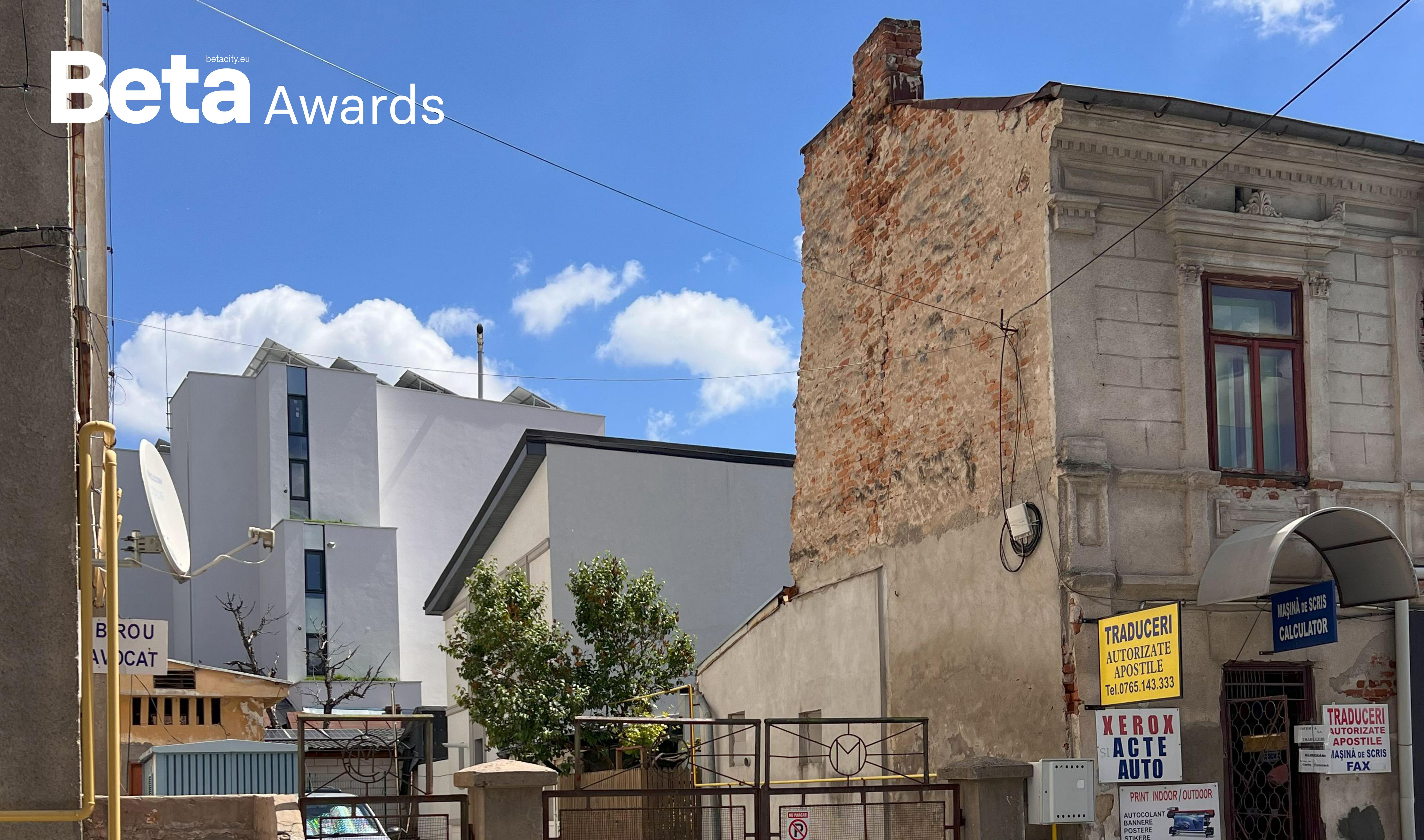
DESFAȘURATĂ NORD STRADA ROMÂNIA MUNCITOARE
